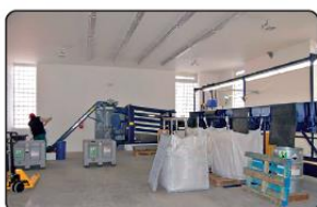
2. celkový pohled na třídíčku baterií
